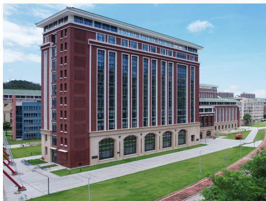
测绘科学与技术学院大楼
